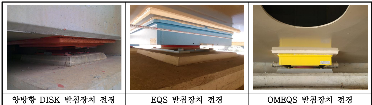
【사진 10.3.12】 교량받침 전경
