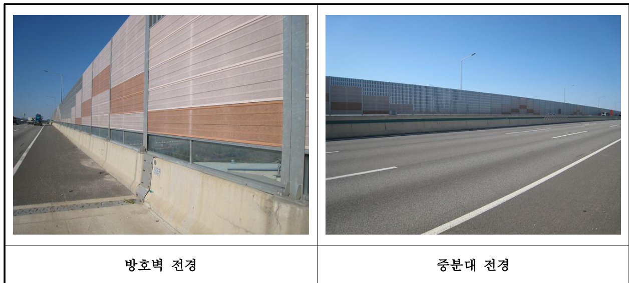
【사진 10.3.23】 방호벽 및 중앙분리대 전경
