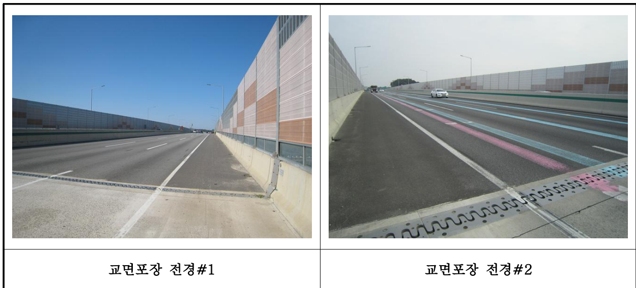
【사진 10.3.19】 교면포장 전경
