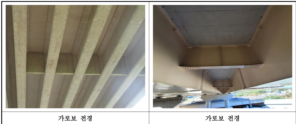
【사진 10.3.6】 가로보 및 세로보 전경
