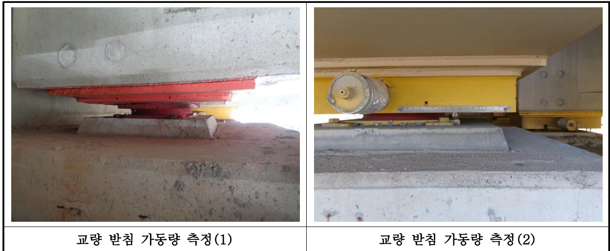
【사진 10.3.15】 교량받침 이동량 측정
