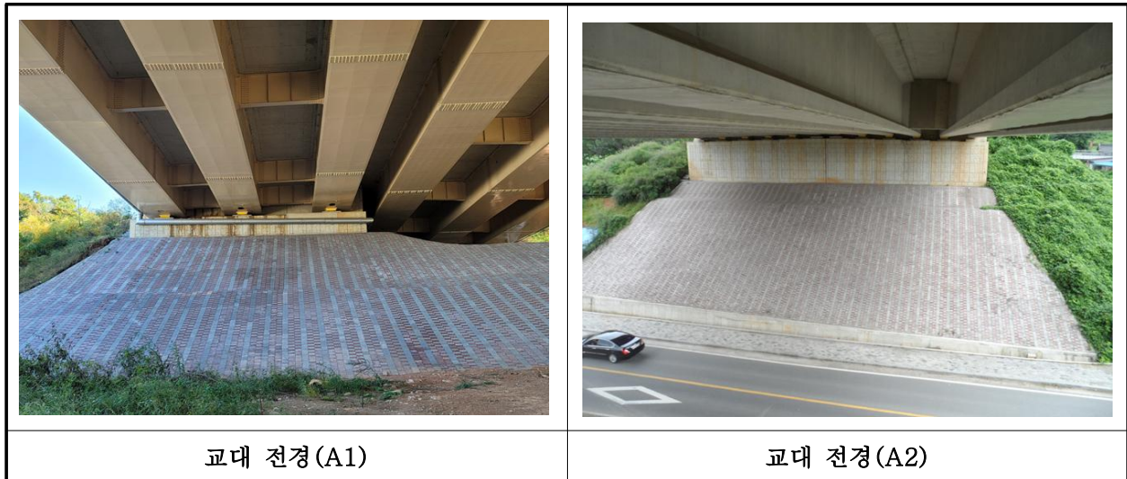
【사진 10.3.8】 교대 전경
