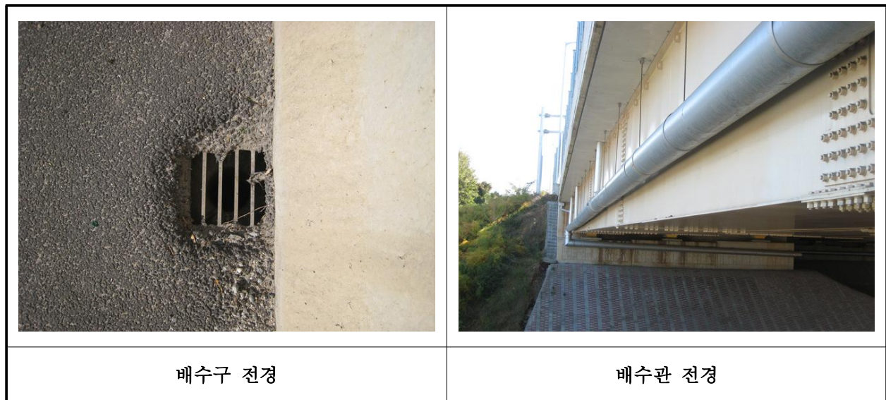
【사진 10.3.21】 배수시설 전경
