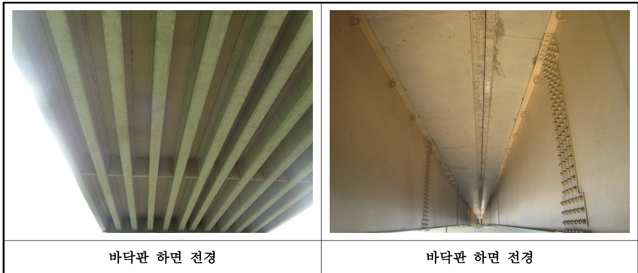
【사진 10.3.2】 바닥판하면 전경
