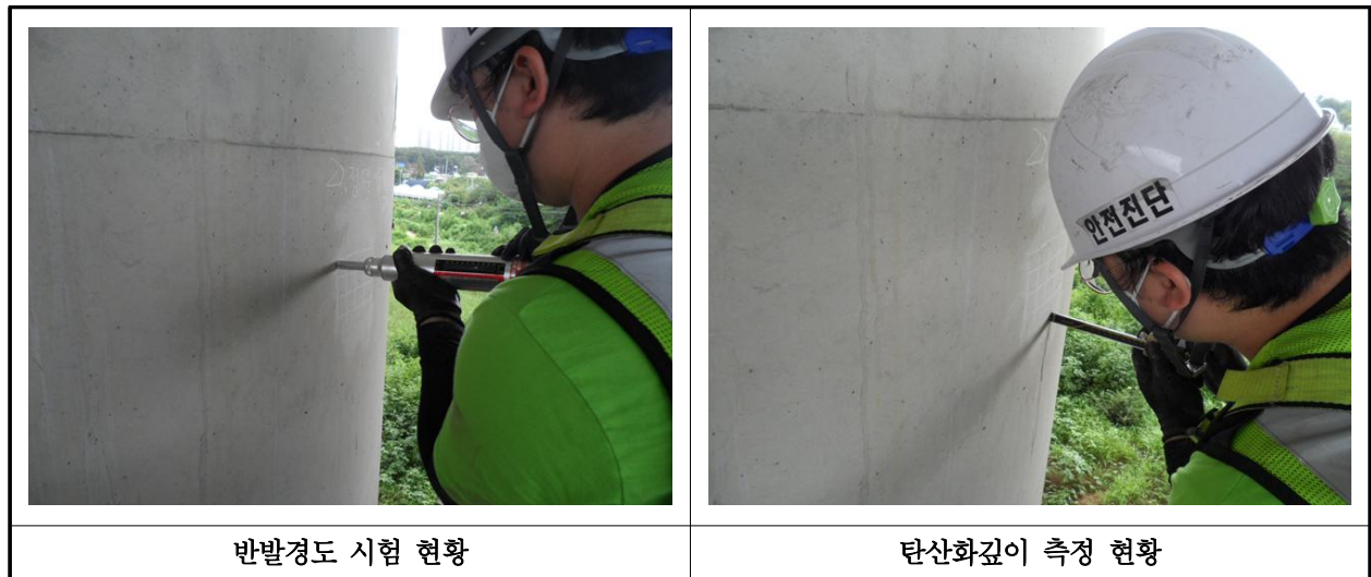
【사진 10.4.1】 콘크리트 내구성조사 현황
